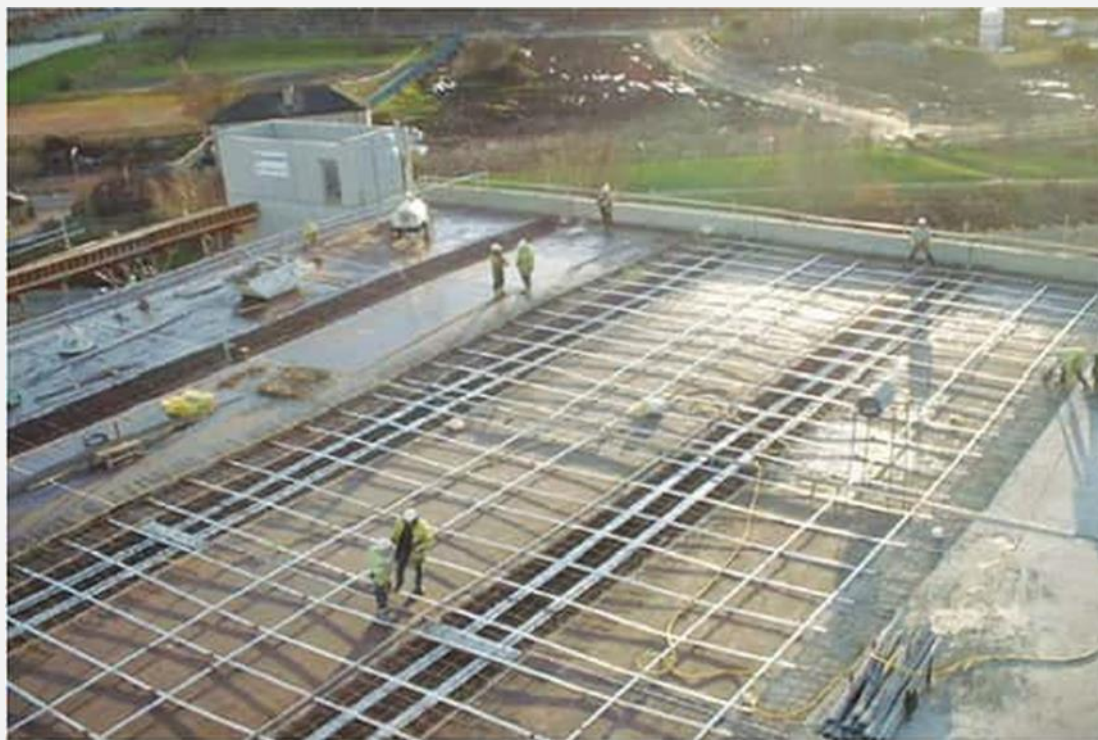
۲. روش غیر چسبیده (unbonded post-tensioned)
