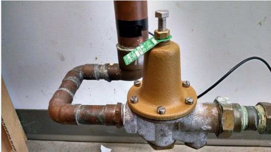
۳. شیر کنترل فشار با دریچه اختلاط ثابت ( Pressure Valve with ) (Fixed Throttle)
